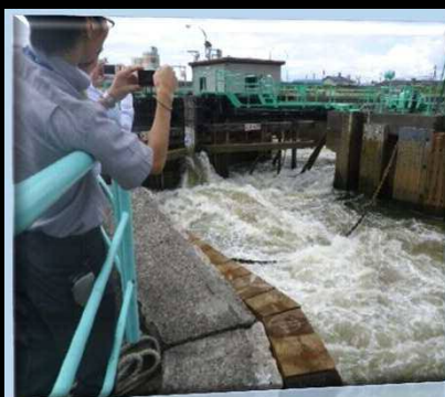
山の下閘門排水機場
