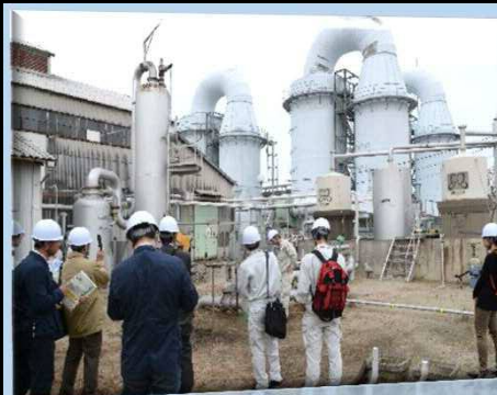
天然ガス採取プラント ((株)東邦アーステック)
