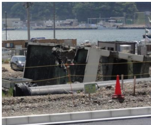
図7 津波で基礎杭より抜け倒れた交番
