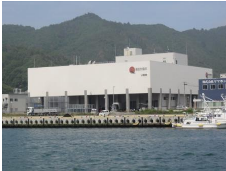
図 1 3 中東・カタールからの資金援助により 建設された冷凍冷蔵施設「マスカー」
