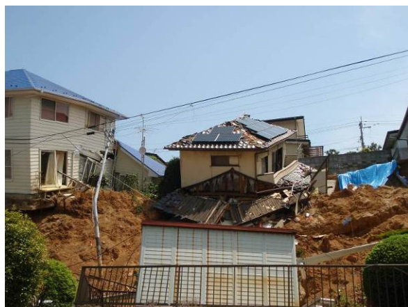
写真 3:地すべりによる住宅倒壊
