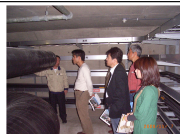
10月(見学会:ハウステンボスコジェネレーションシステム)
